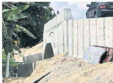
■桥底加了一个巨型沟，好让河水顺利排放。
