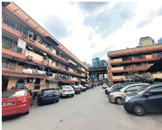
PKNS akan membuat kajian berhubung kesan retakan di Flat PKNS Jalan Tun Razak dalam tempoh segera.
